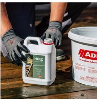
Wässern Sie dazu die gesamte Fläche, um die Saugfähigkeit zu reduzieren. Anschließend wird mit einem Pinsel oder einer Bürste der ADLER Holzentgrauer aufgetragen. Nach 10 bis 20 Minuten Einwirkzeit waschen Sie das Terrassenholz mit viel Wasser und einer Nylon- oder Wurzelbürste wieder ab.
