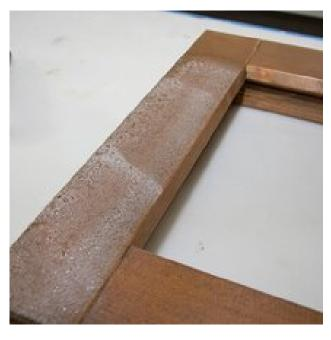
...und einige Minuten einwirken lassen. Die aufgesprühte Schicht reagiert mit der bestehenden Beschichtung und schäumt dabei leicht auf.
